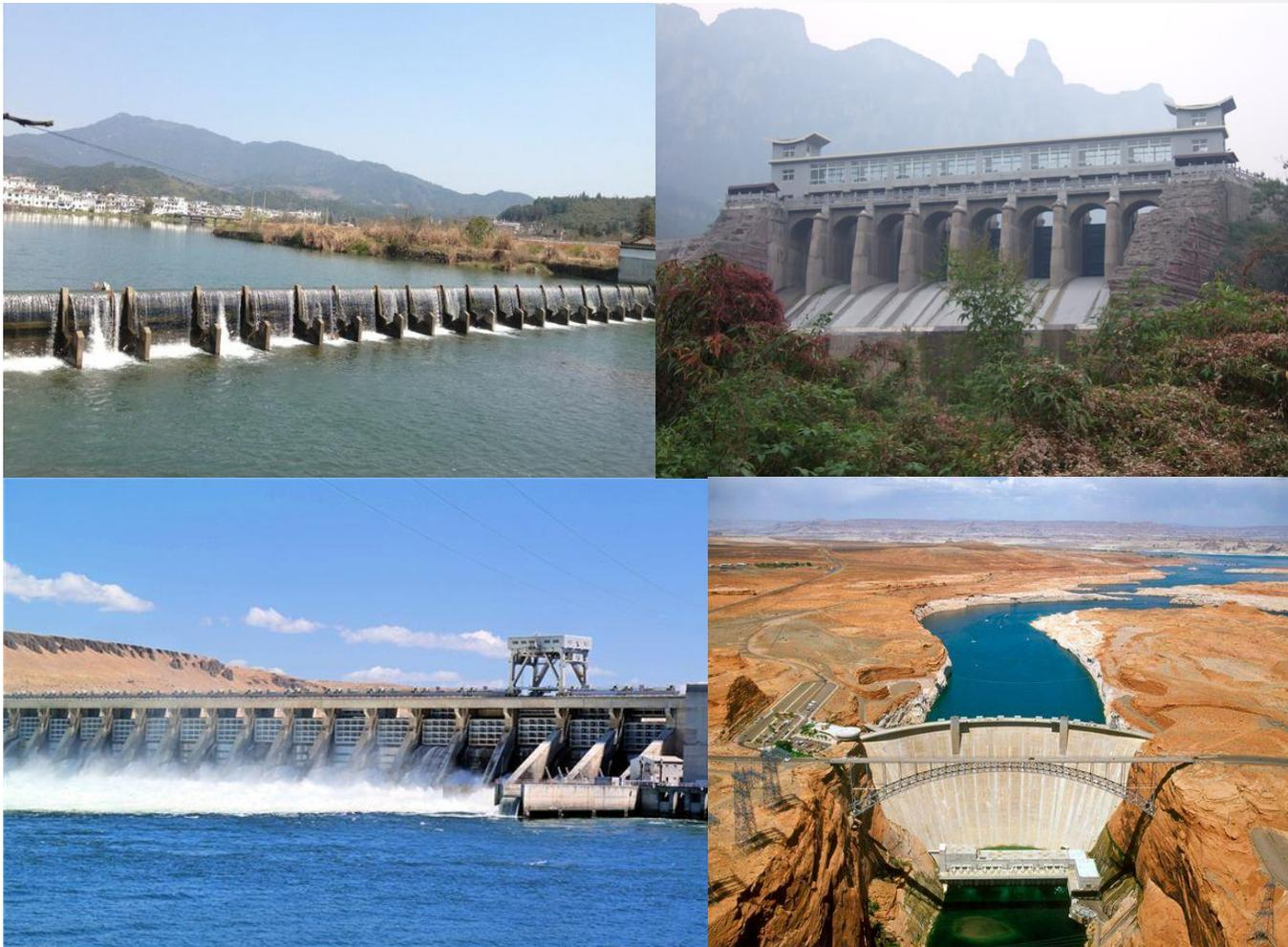
水坝工程指拦截江河水流，调蓄水量或壅高水位的人工挡水建筑物，这种建筑物可形成水库，调节径流，满足防洪、发电、航运、给水等需要，也通称“拦河坝”。坝是水利枢纽中的主体建筑物，在全部水利工程的工程量和投资中占有较大比重，工作条件和施工条件复杂。
